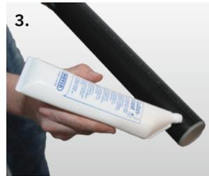
3. Optiline Gleitmittel dünn und gleichmäßig auf das Einsteckende auftragen (wichtig: keine Öle und Fette verwenden).
