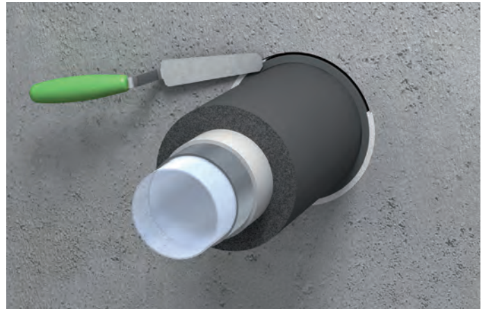
Rest- bzw. Ringspalt rauchgasdicht (mit z.B. BIS Pacifyre® FPM Brandschutzmörtel) verschließen.
