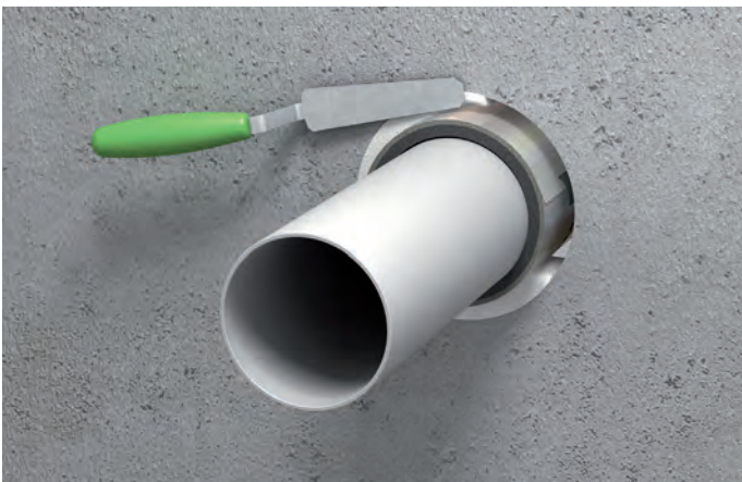
Restspalt rauchgasdicht (mit Tangit® FP 550 oder BIS Pacifyre® FPM Brandschutzmörtel) verschließen.
