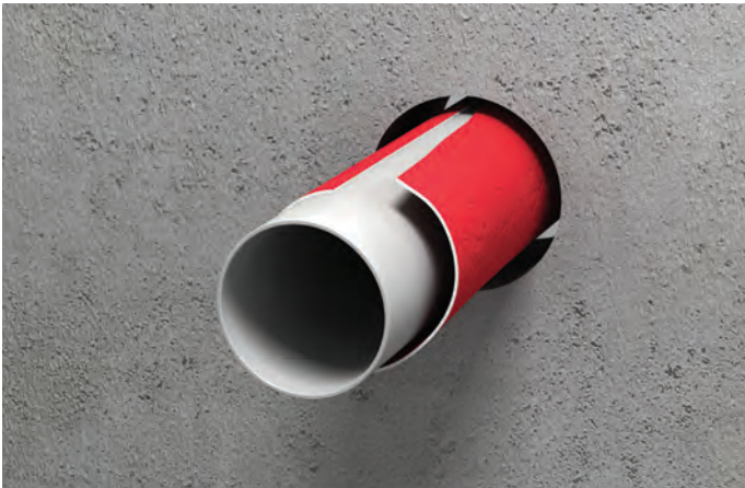
Rohrleitung (ggf. mit PE-Schallschutzschlauch) installieren.
